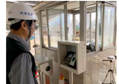
運用智慧科技進行工地管理
