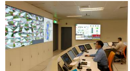
Tpark 智慧防災中心
