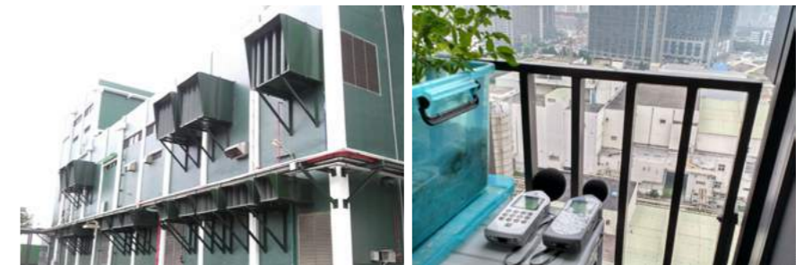
排風口安裝消音箱
