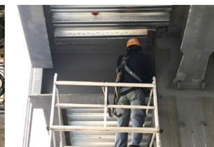
高架作業確實穿戴安全帶，並鉤掛在欄杆上
