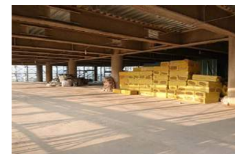
施工物料放置整齊
