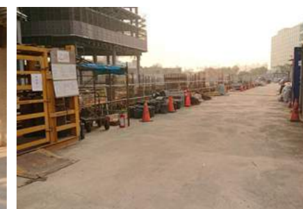
施工物料放置整齊
