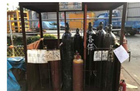
危險物旁放置滅火器
