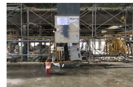
預防感電 - 電線和電箱架高
