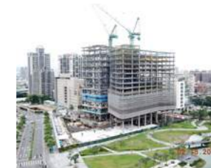
TPKC、TPKD 已完成建築物主體鋼構工程
