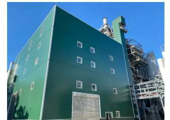
新設汽電廠外觀圖
